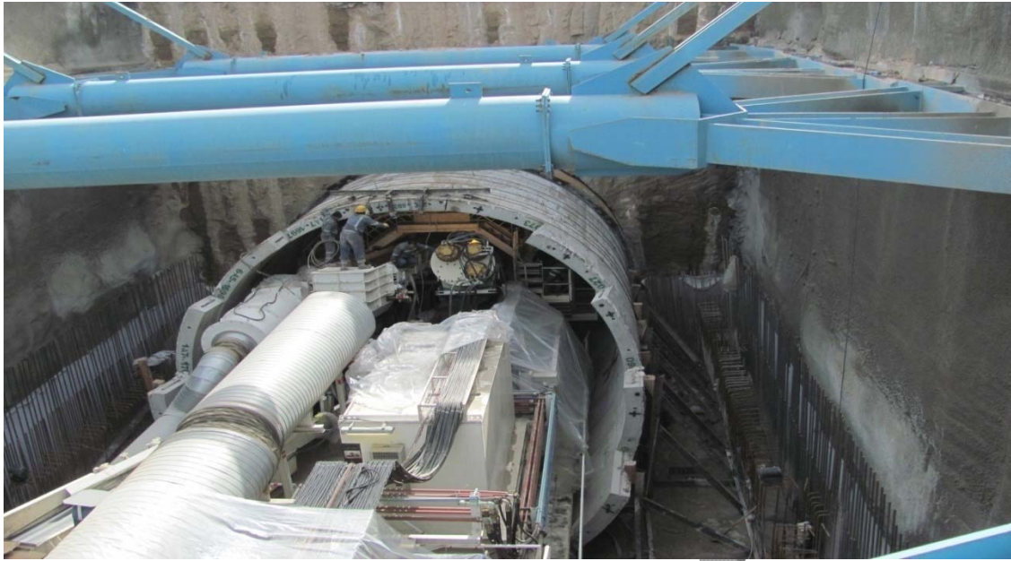
تصویر ۴ - نمایی از اجرای روش رینگ ناقص در ایستگاه A2 مشهد
