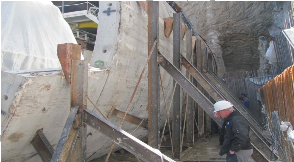
تصویر ۵ - مهار رینگ ها جهت جلوگیری از حرکت رینگ و انحراف ماشین حفار در ایستگاه A2 مشهد
