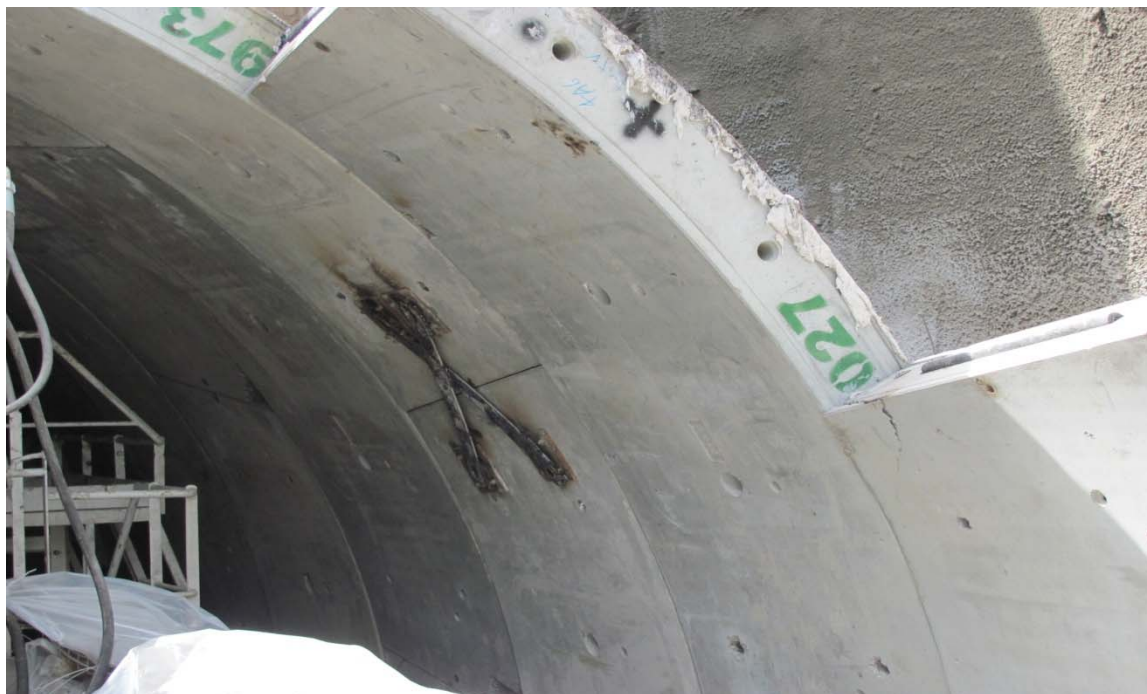
تصویر ۶ - نصب پلیت و جوشکاری توسط تسمه جهت ایجاد رینگ یکپارچه در ایستگاه A2 مشهد
