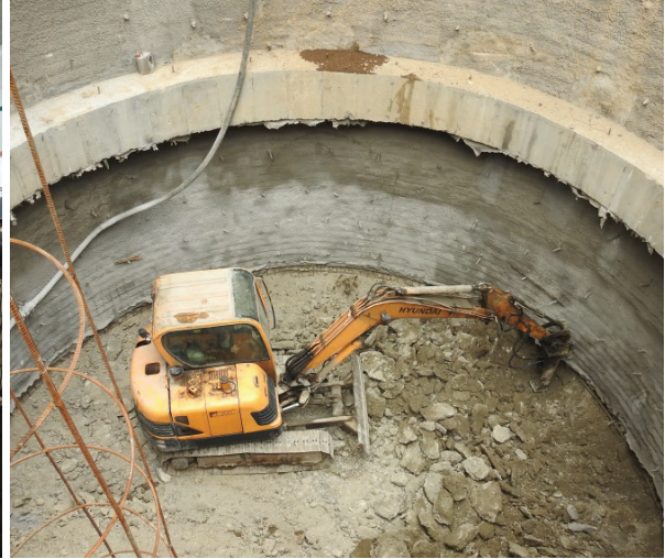
شکل ۱۵- عملیات اجرایی شفت ۲ لینگ ارتباطی
