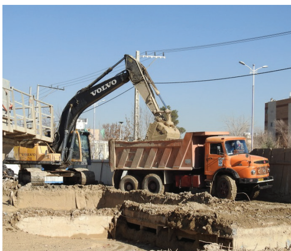
شکل ۱۳- عملیات حمل گل از چال گل حفاری
