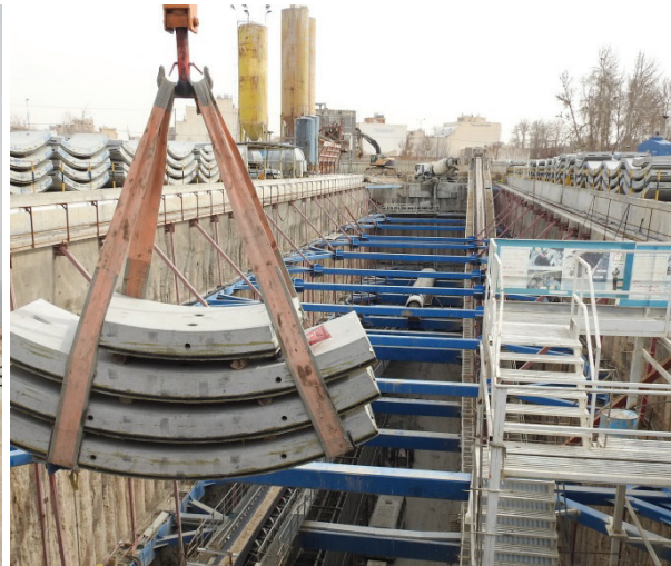
شکل ۶- شارژ سگمنت به داخل تونل
