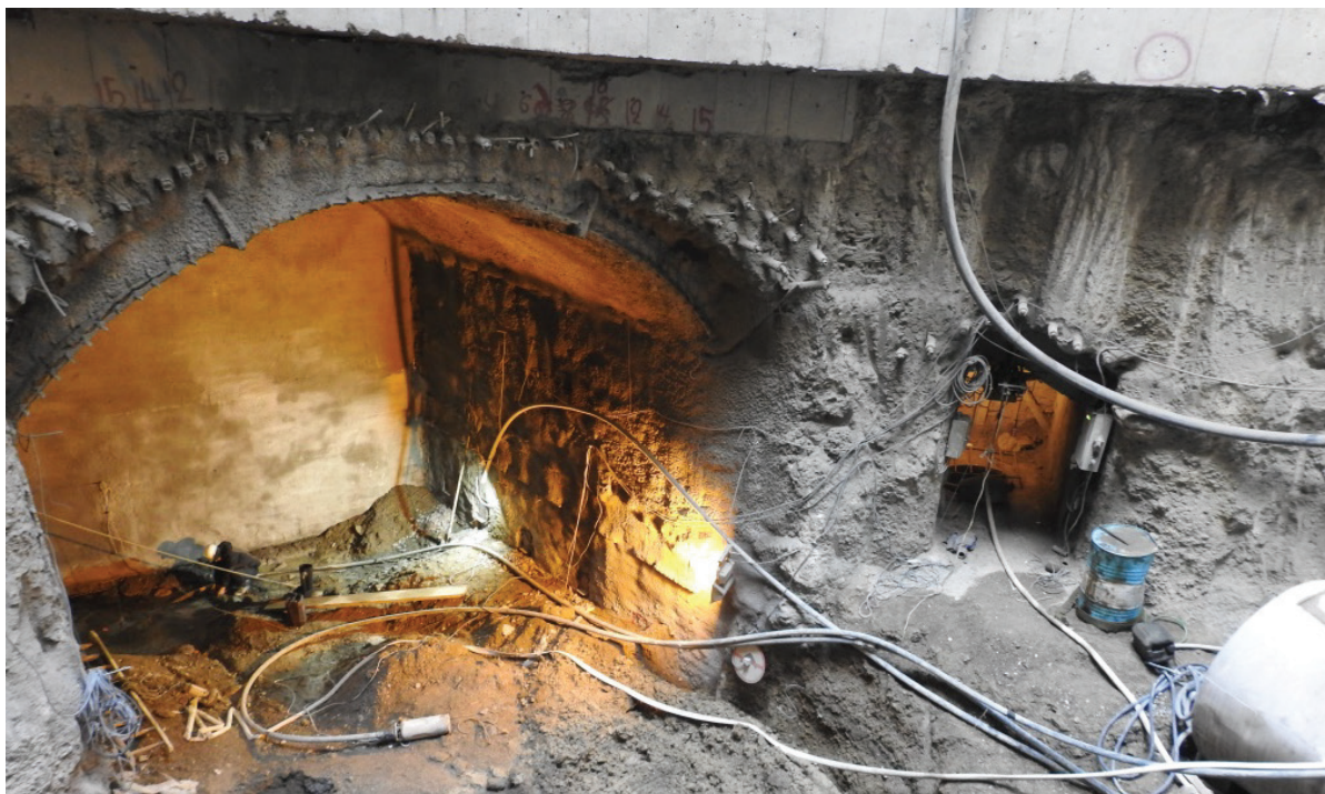
شکل ۲- اتمام حفاری فوقانی و شروع حفاری تحتانی سازه نگهدارنده ادیت شفت ۱ لینگ ارتباطی خط ۱ به ۲ قطار شهری اصفهان
