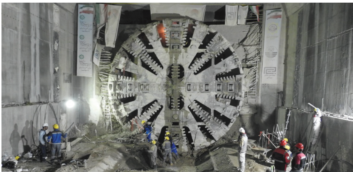
شکل ۱- ورود دستگاه حفار مکانیزه (TBM) به ایستگاه خلجا (ایستگاه خلجا سومین ایستگاه مسیر در بخش غربی خط ۲ قطار شهری اصفهان می‌باشد)
