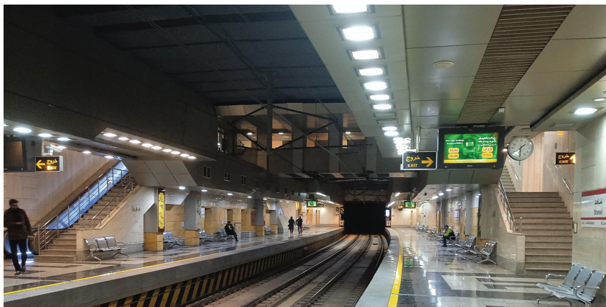
شکل ۴- پله‌های دسترسی به سکو در ایستگاه شاهد - خط یک شیراز
