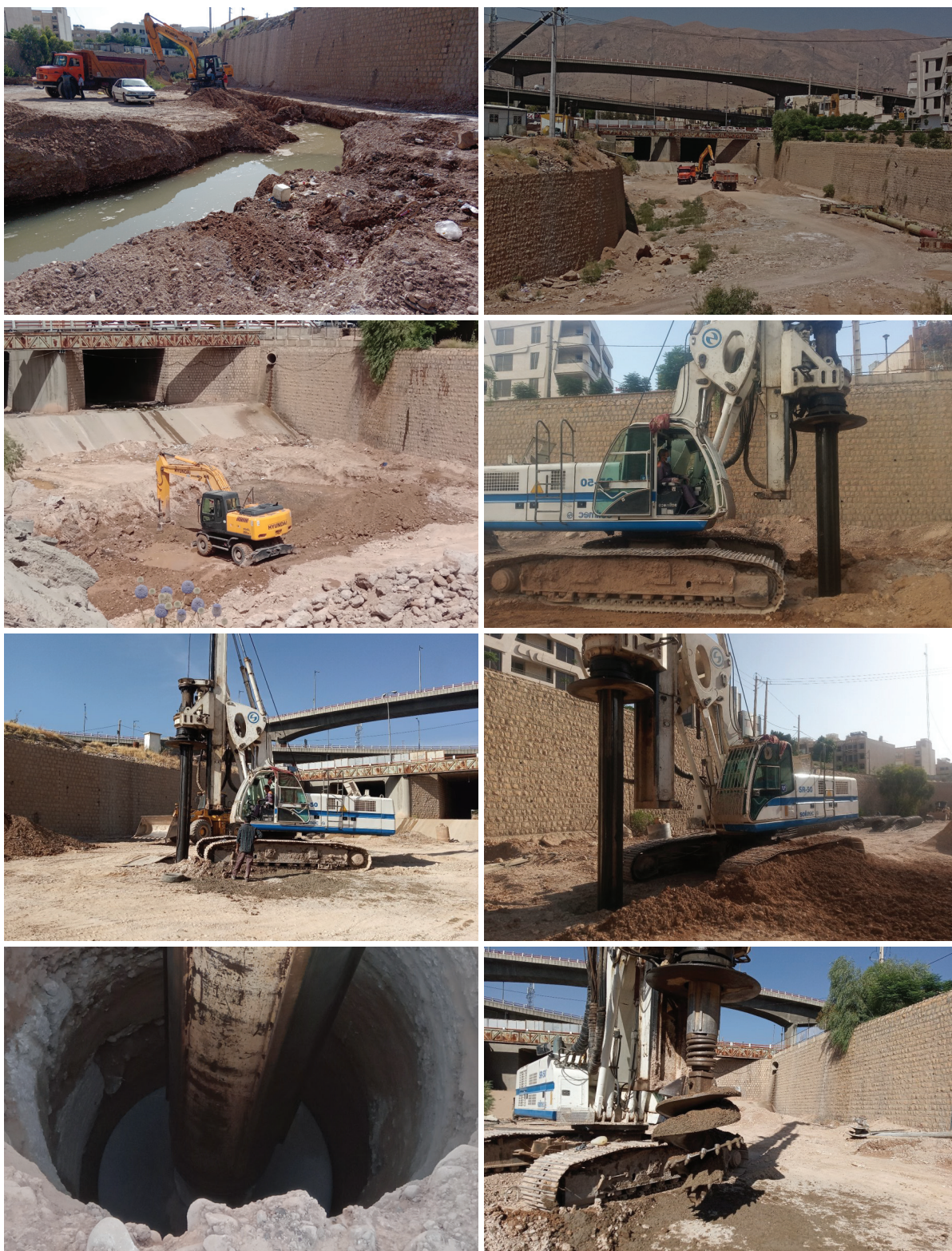
شکل ۳- اجرای شمع در بستر رودخانه
