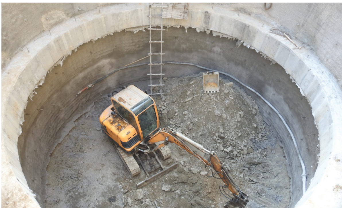
شکل ۳- شروع حفاری شفت دسترسی دوم به تونل ارتباطی خط ۱ به ۲ قطار شهری اصفهان
