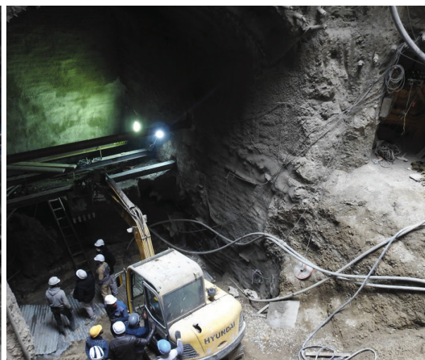
شکل ۸- عملیات اجرایی تونل ادیت در شفت لینک ارتباطی
