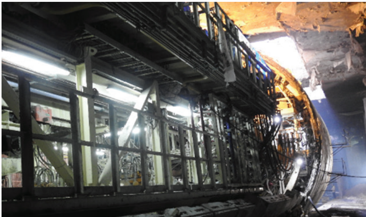
شکل ۲- سیستم پشتیبان دستگاه S525
