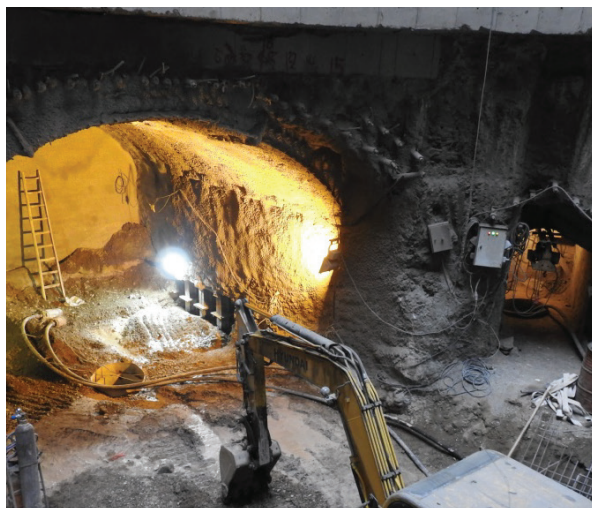
شکل ۱۰- عملیات اجرایی در شفت ۱ لینک ارتباطی
