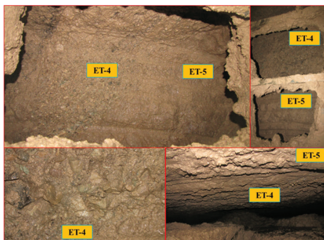
شکل ۲۱-نمایی از جبهه کار مختلط در مسیر حفر تونل
