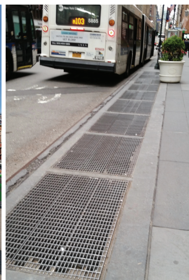
شکل ۴- هواکش کار شده در کف خیابان New York - آمریکا
