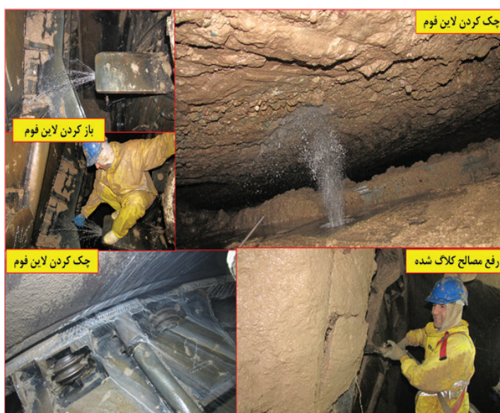
شکل ۹- نمایی از عملیات تمیزکاری و چک کردن لاین‌های فوم
