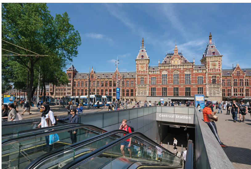
شکل ۵- ورودی ایستگاه Centraal Station در شهر آمستردام - هلند (حذف دیوار و شفت ورودی با هدف استتار و حفظ نمای شهری)
