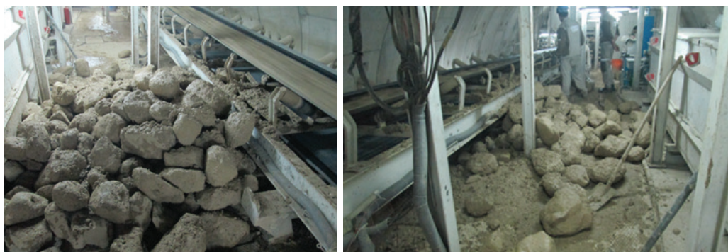
شکل ۶-نمایی از بولدرهای حفاری شده توسط ماشین EPB-TBM
