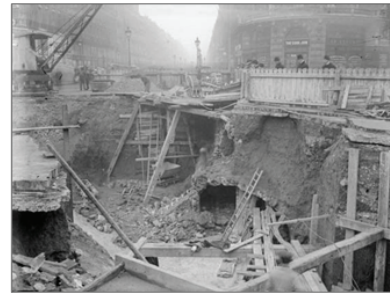
شکل ۲- عملیات اجرایی احداث ایستگاه پیش از سال ۱۹۰۰
