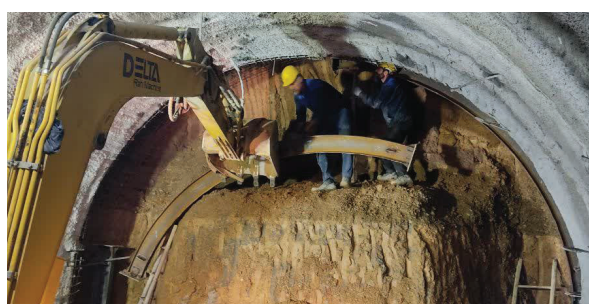
شكل ۵ - عمليات حفارى جهت نصب قاب‌هاى هدينك ضلع شمالى تونل لينك ارتباطى
