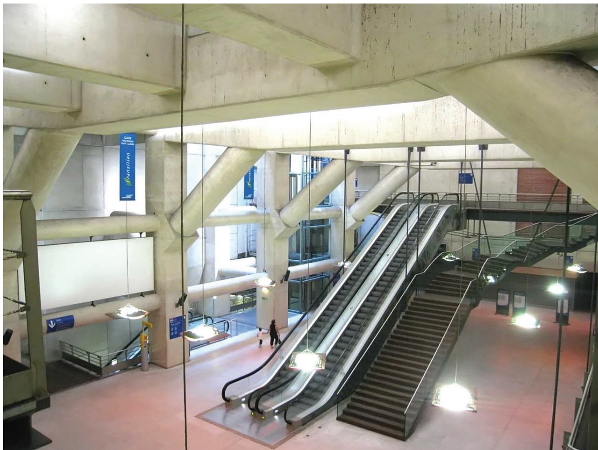
شکل ۱۰- پله‌های سالن شرقی ایستگاه
