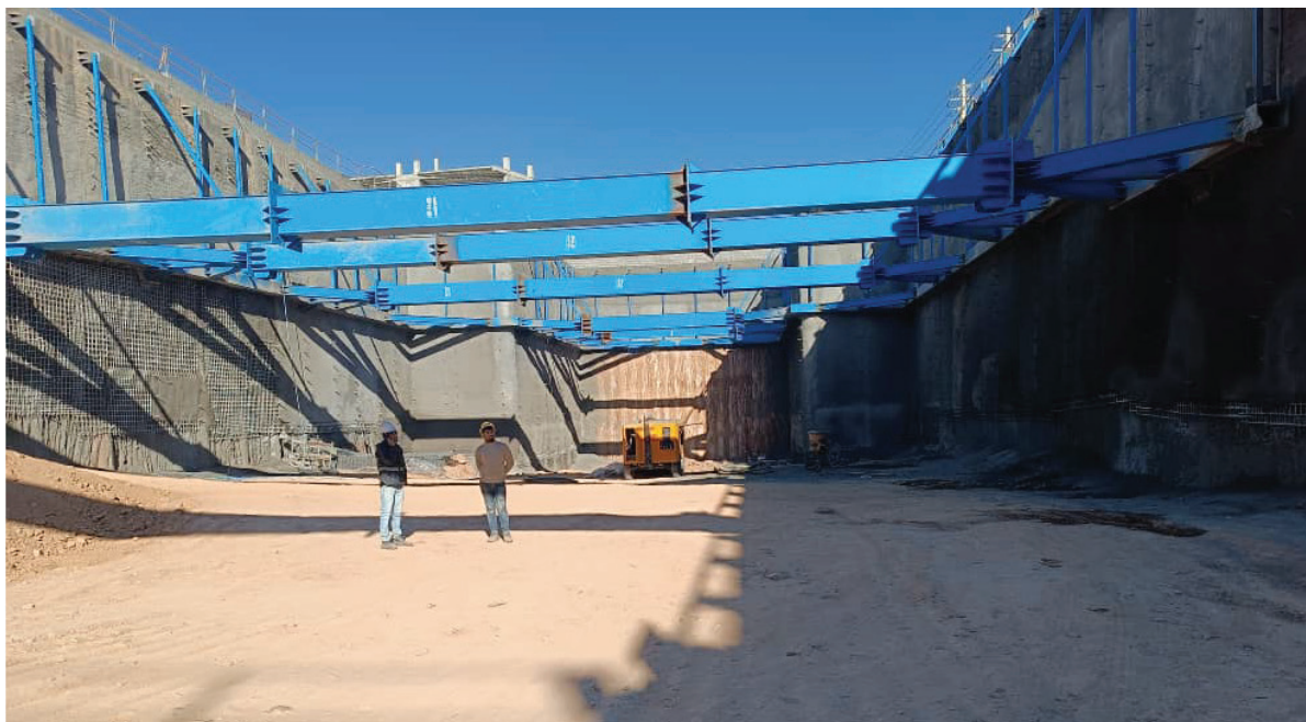
شکل ۴- عملیات اجرایی ایستگاه بهشتی
