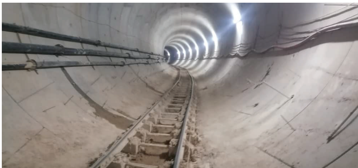
شکل ۳- عملیات اجرایی فاز دوم خط دو قطار شهری شیراز
