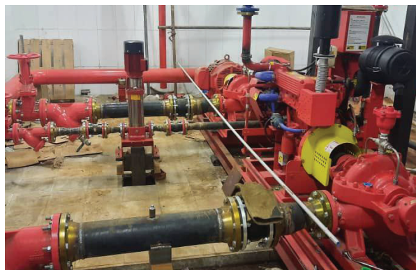
شکل ۳ - نمایی از عملیات بوستر پمپ‌ها، لوله‌کشی و نصب شیرآلات
