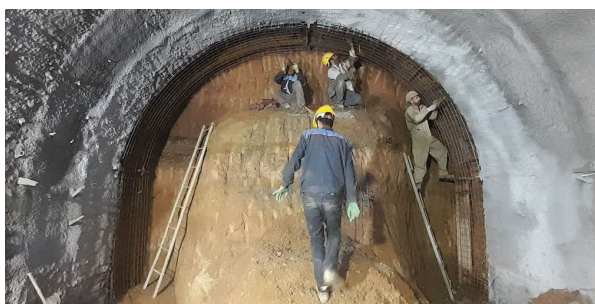
شكل ۴ - نمايى از عمليات نصب و تحكيم قاب‌هاى هدينك ضلع شمالى تونل لينك
