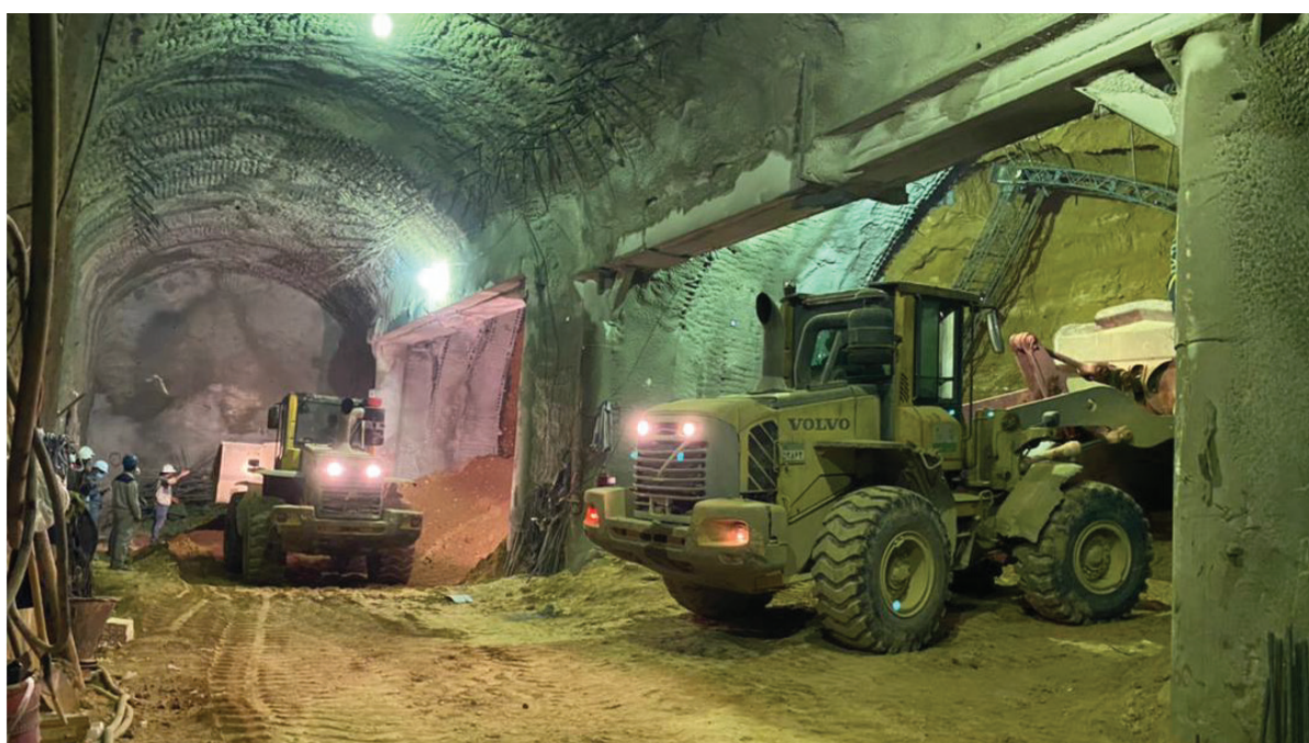
شکل ۳- سازه کراس کات (دسترس به محل شروع حفاری کراس اور)
