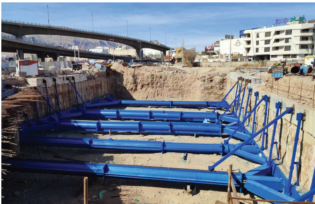
شکل ۷- عملیات اجرایی ایستگاه میرزای شیرازی
