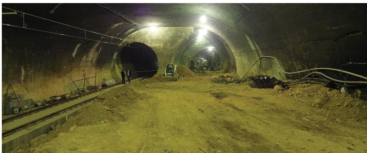
شکل ۲- بزرگترین مقطع لاپینگ شده کراس اور
