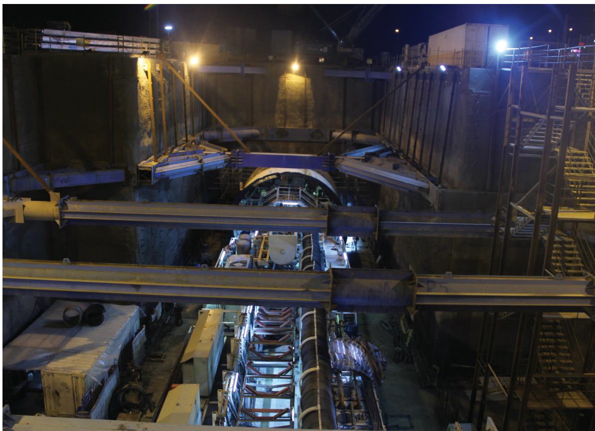
شکل ۲- نمای شفت ورود TBM در ایستگاه شهرک گلستان
