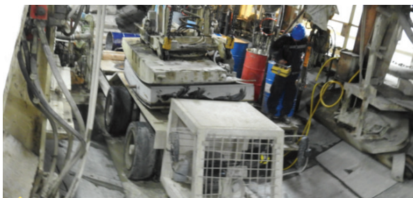
شکل ۲- عملیات نصب رینگ در تونل مکانیزه
