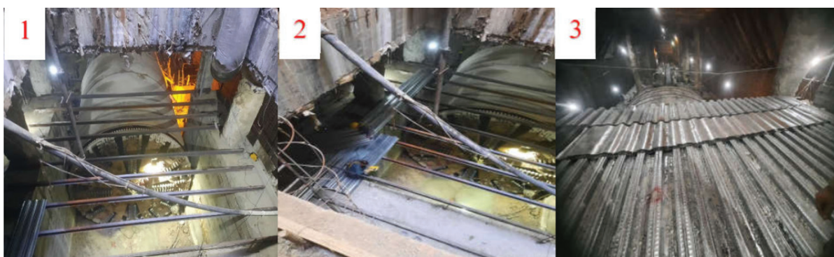
شکل ۹- مراحل اجرای سقف محفظه نگهدارنده گروت
