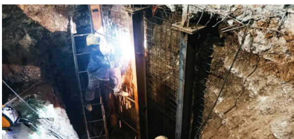
شکل ۸- عملیات جوشکاری و نصب پایه قاب‌های تونل لینک ارتباطی
