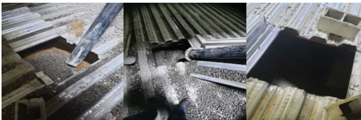
شکل ۱۰- پر کردن فضای خالی بین رینگ و دیواره‌های محفظه نگهدارنده گروت
