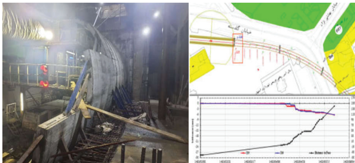
شکل ۱۱- اعمال فشار تعادلی زمین در بازه طراحی شده و نمودار نشست در محدوده رینگ‌های ابتدایی (خروج دستگاه حفار از ایستگاه شماره ۴)
