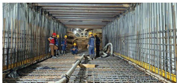
شکل ۷- عملیات بتن‌ریزی کف محدوده سهرای تونل لینک ارتباطی
