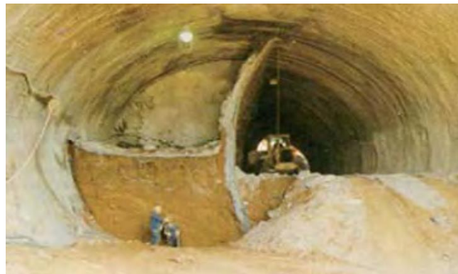
شکل ۳-۱۱: نمایی از اجرای روش دیوار میانی با کف بند موقت (CRD)
