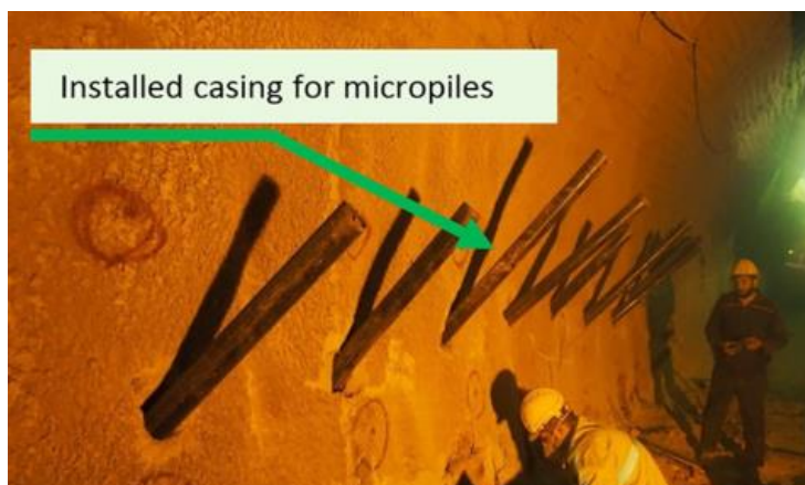
شکل ۳-۲۴: نمونه‌ای از اجرای میکروپایل در داخل تونل
