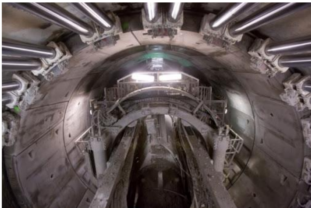
شکل ۲-۳۲: نمایی از جک‌های پیشران دستگاه حفار در حال اعمال فشار بر ضخامت سگمنت‌های نصب شده
