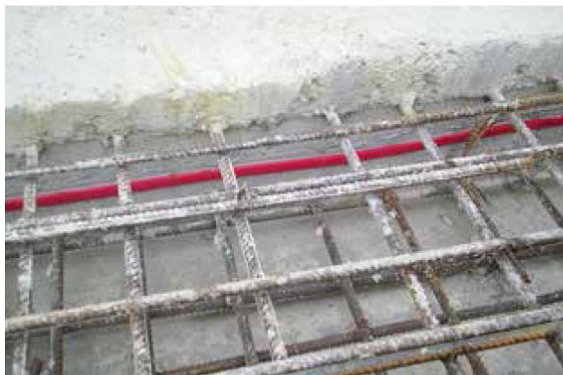
شکل ۳-۲۶- اجرای واتراستاپ متورم شونده در درز
