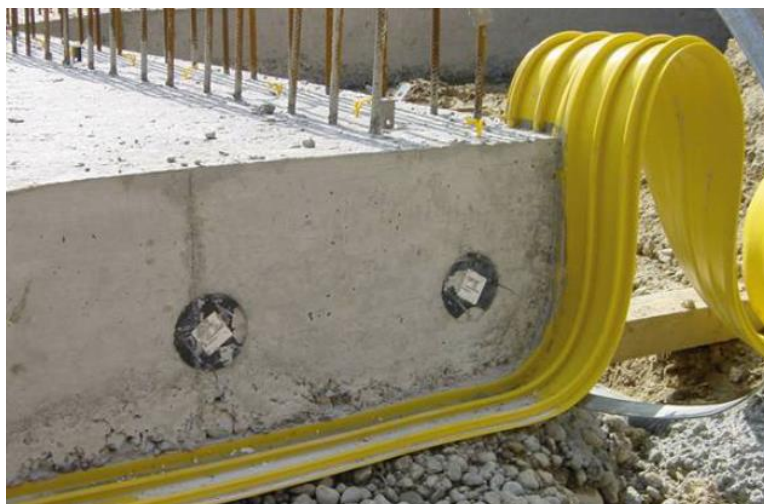
شکل ۳-۲۸- آب‌بندی درز به وسیله واتراستاپ خارجی
