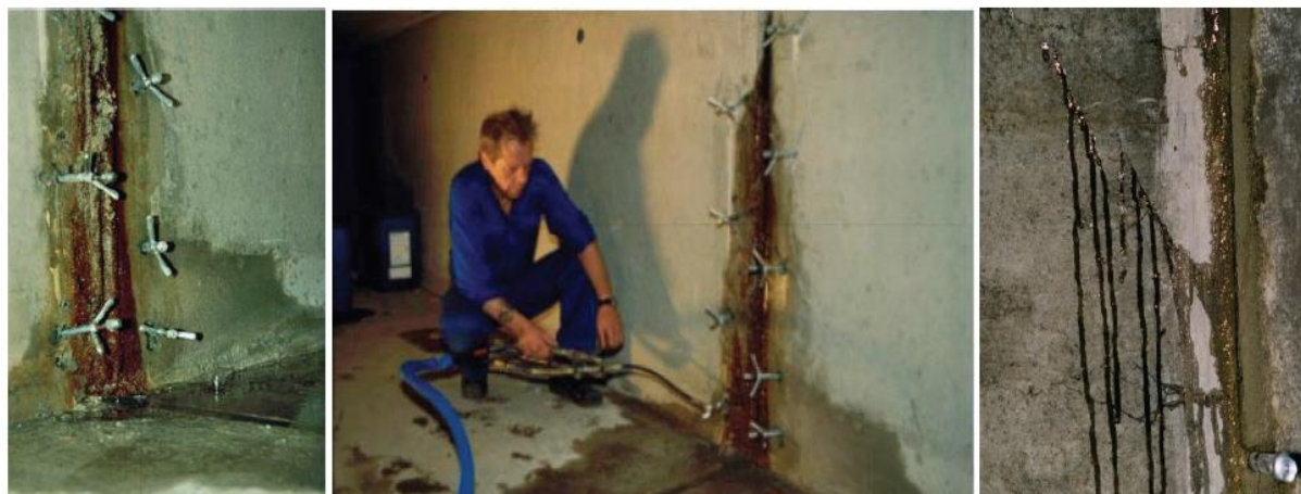
شکل ۶-۹- عملیات تزریق در درزهایی با نشب آب
