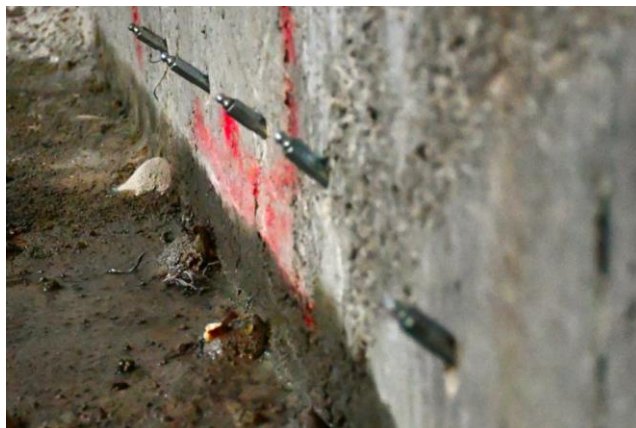
شکل ۳-۶- نمایی از پکر گذاری و تزریق در درز اجرایی کف و دیواره
