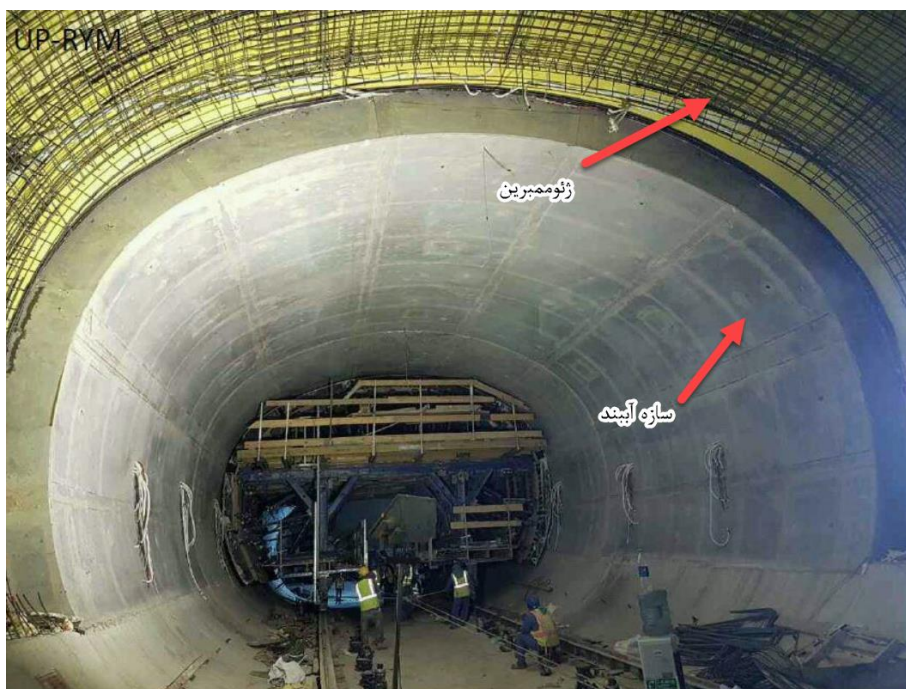
شکل ۱-۱۸- نمایشی از ترکیب دو روش آببندی به وسیله غشاء ژئوممبران و سازه آببند
