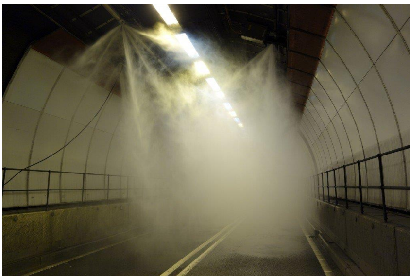
شکل ۳-۴- نمایی از دبی آب ورودی به تونل جهت اطفاء حریق
