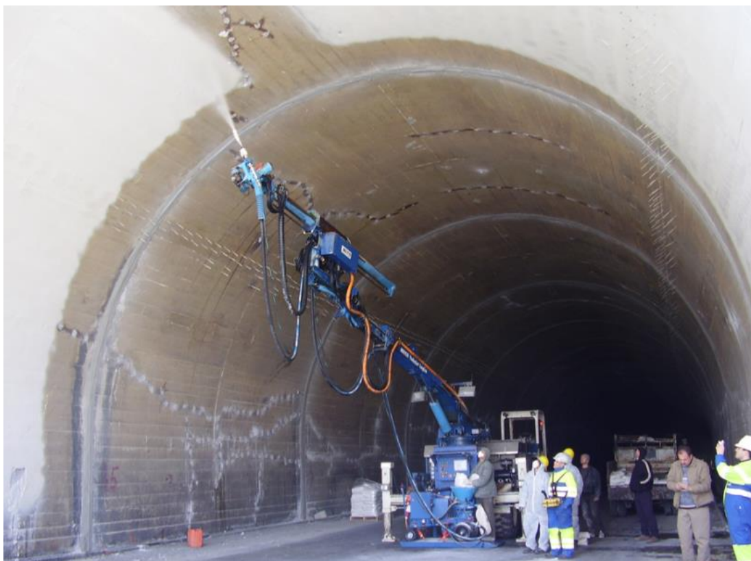
شکل ۹-۱- استفاده از آب‌بند بر پایه سیمان و مواد بلوری شونده در سازه زیرزمینی
