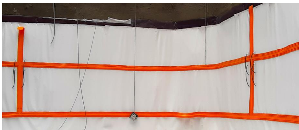
شکل ۳-۱۵- نمایی از واتراستاپ پروفیلی جوش شده به ژئوممبران PVC
